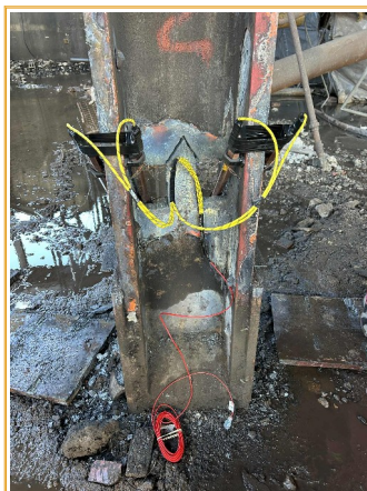
Connexion du détonateur aux charges explosives linéaires. Photos: courtoisie Eric Lamanque
