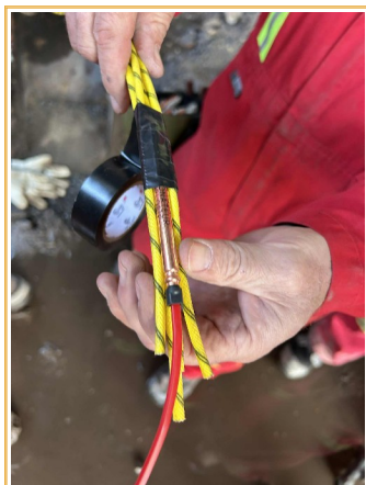
Connexion du détonateur aux charges explosives linéaires. Photos: courtoisie Eric Lamanque
