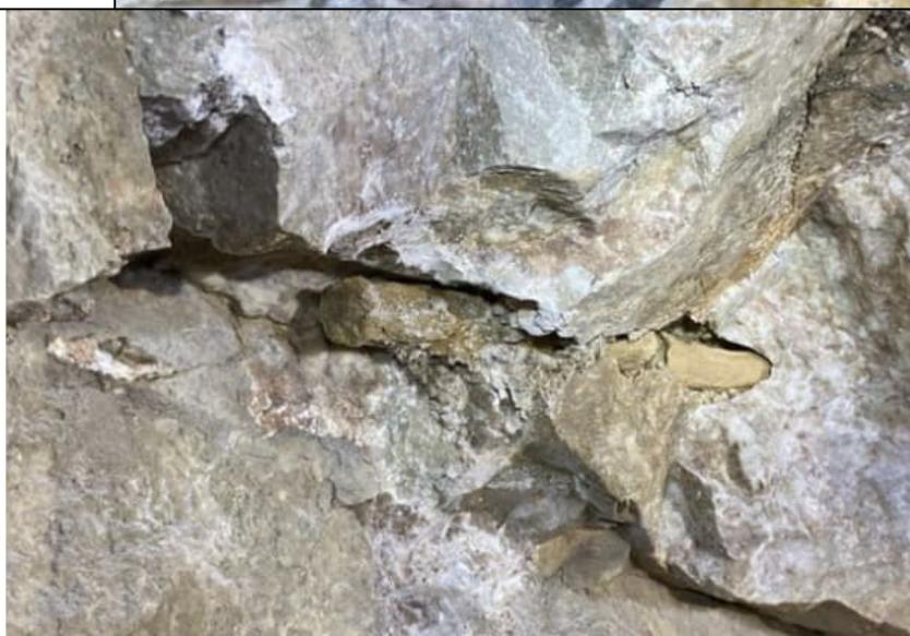
Résultats de l'inspection du tunnel - Explosifs dans des trous verticaux
