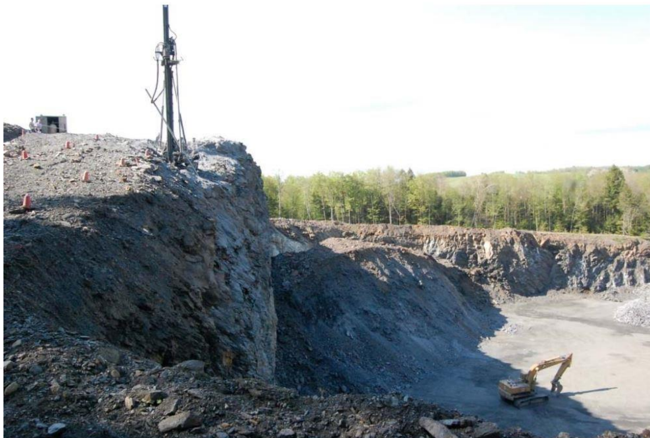
Figure 1 : Position de la foreuse sur le sommet de la paroi le 5 mai 2010 (source : CSST).
