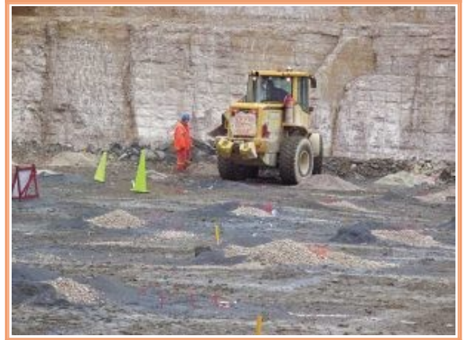
Mise en place du collet avec de la pierre concassée comme matériel de bourre
