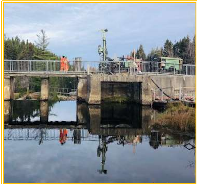
Daniel Cantin et Sheldon Coudé, forages et ancrages, barrage les Murailles à Saguenay,
