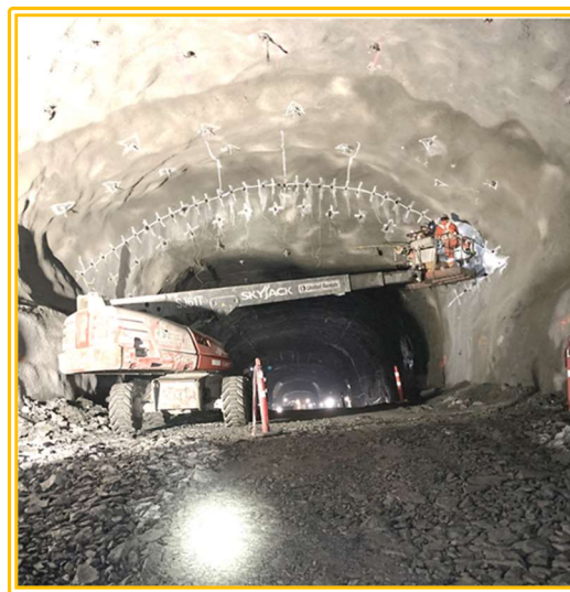
PHOTO TIRÉE D'UN RAPPORT DE LA CNESST Portion du tunnel sous le mont Royal juste avant un dynamitage
