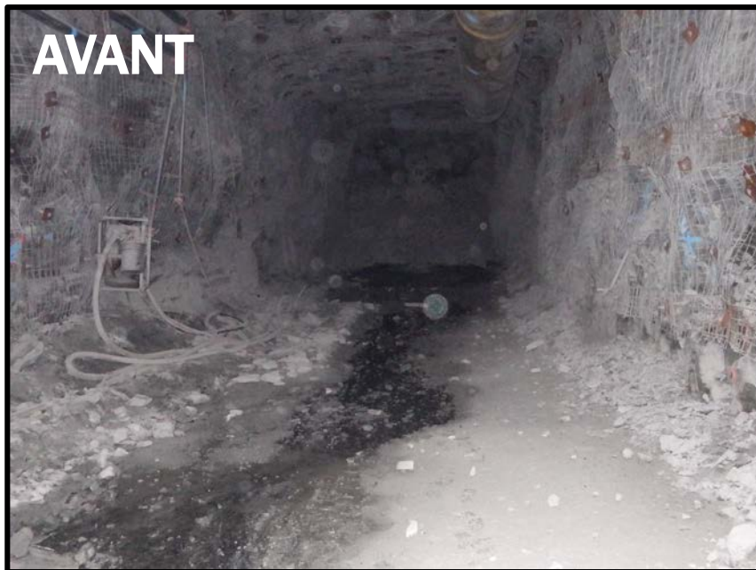
Figure 4 : Excavation non endommagée d'une mine souterraine (tiré de Morissette, 2017)
