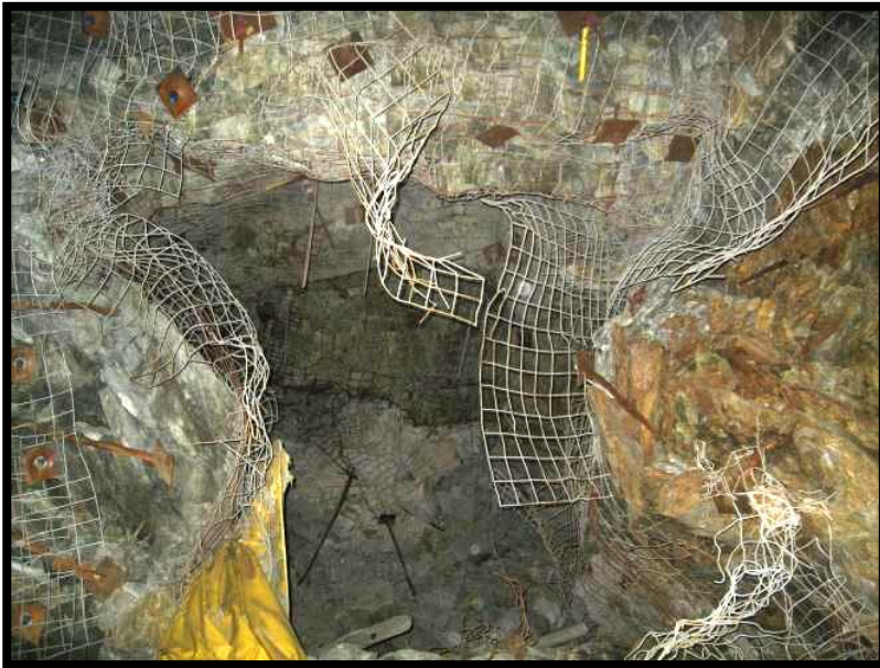
Figure 9 : Déformation à la mine LaRonde (tiré de Giroux, 2016)
