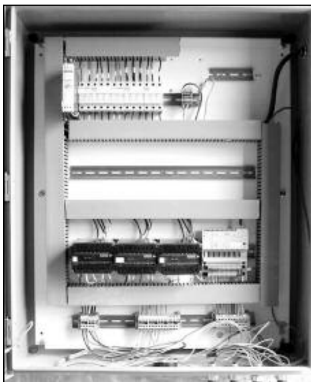
Figure 1: Module analogique à entrée/sortie avec carte de communication Ethernet.
