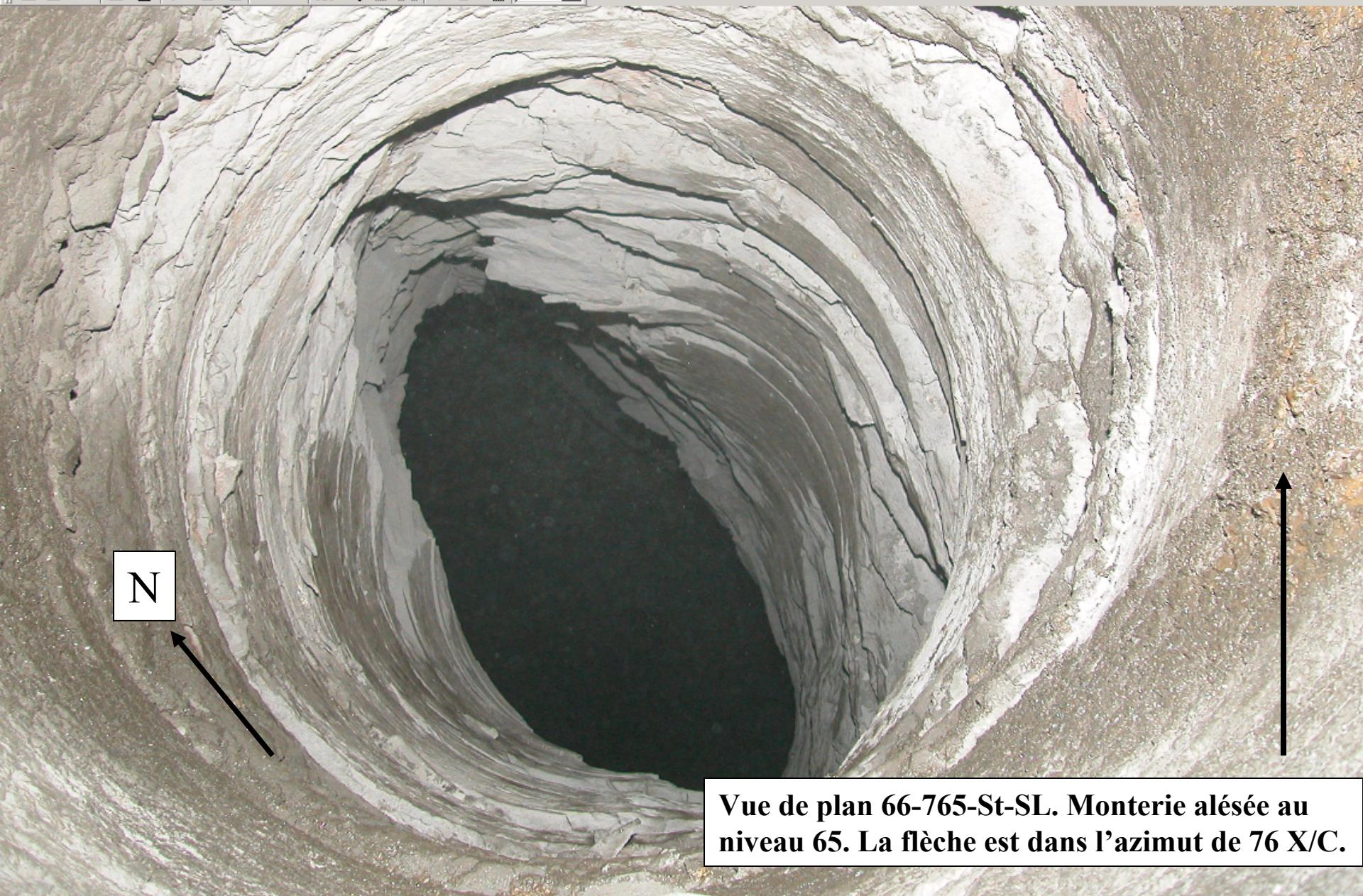
**Vue de plan 66-765-St-SL. Monterie alésée au niveau 65. La flèche est dans l'azimut de 76 X/C.**
