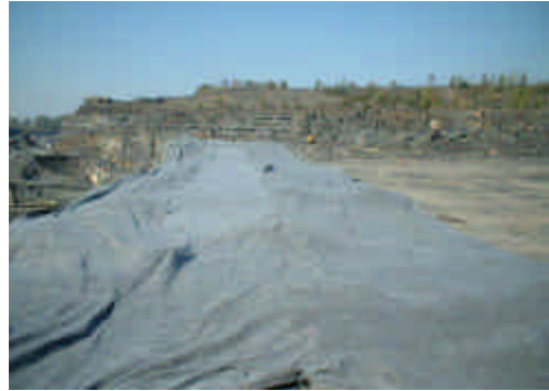
Couverture avec membrane géotextile
