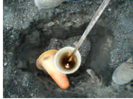
Vérification des verticalités de forage
