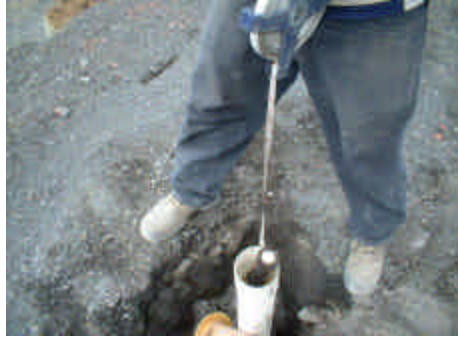
Vérification des verticalités de forage
