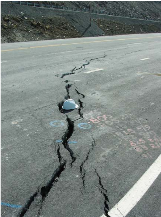
Photo 9 : Fissures associées à l'amorce de rupture en dièdre identifiée sur la photo 8.
