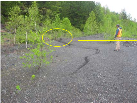
Photo 15: Point "A", fissure dans la halde .
