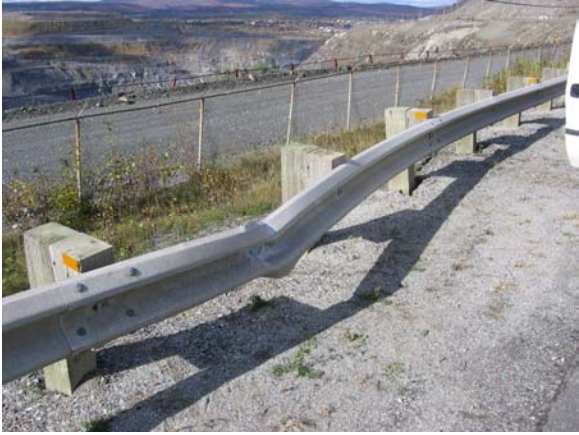
Photo 7 : Déformation de la glissière secteur sud.
