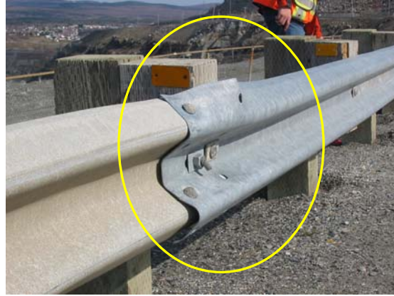
Photo 12 : Nouvelle déformation de la glissière qui avait été réparée à l'automne 2009.
