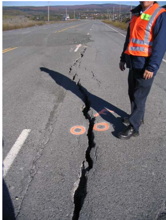
Photo 10 : Élargissement des fissures existantes.
