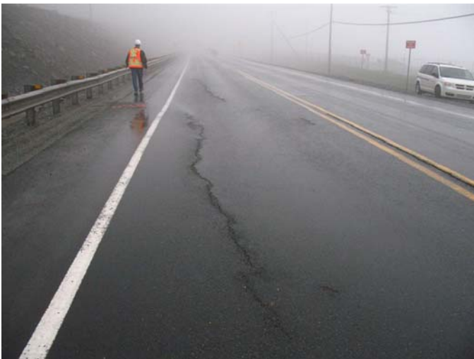
Photo 19: Fissuration et déformation du chemin temporaire dans le secteur nord .
