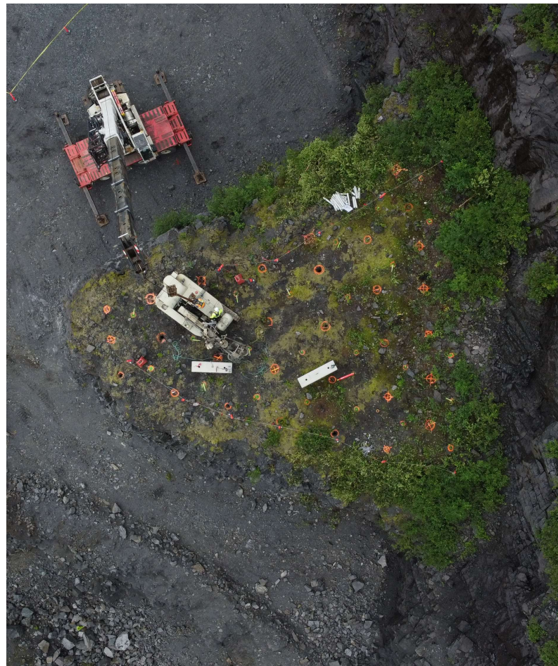
Implantation des trous de forage
