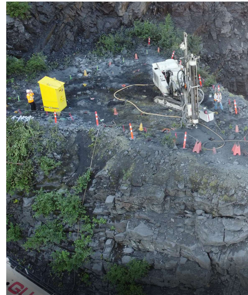
Arrêt du forage pour effectuer des vérifications
