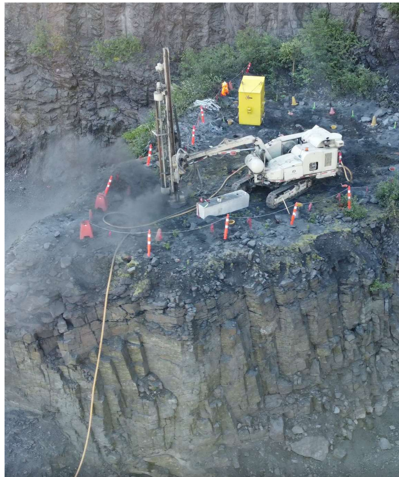
Forage avec travailleurs dans la cloche
