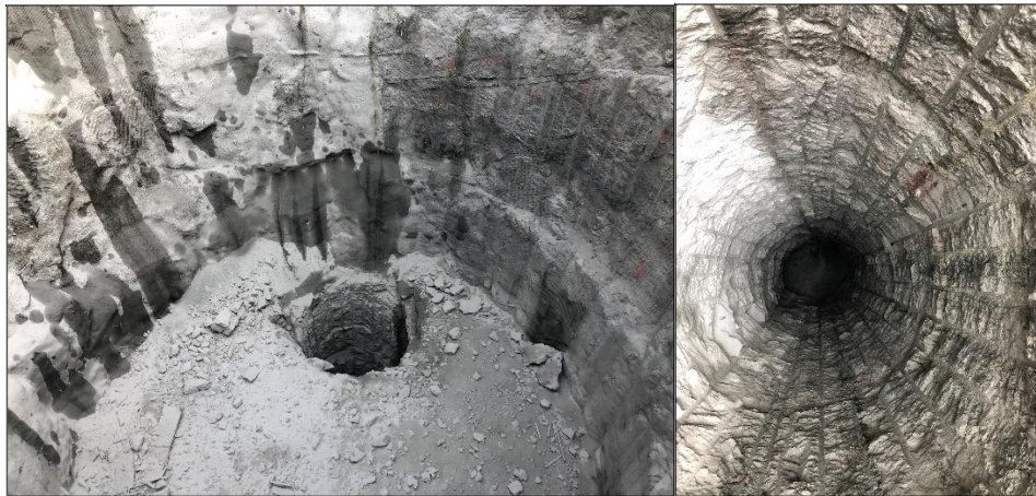
Figure 4. Trous périmétriques du puits de la cheminée d'équilibre présentant un contrôle adéquat de déviation
