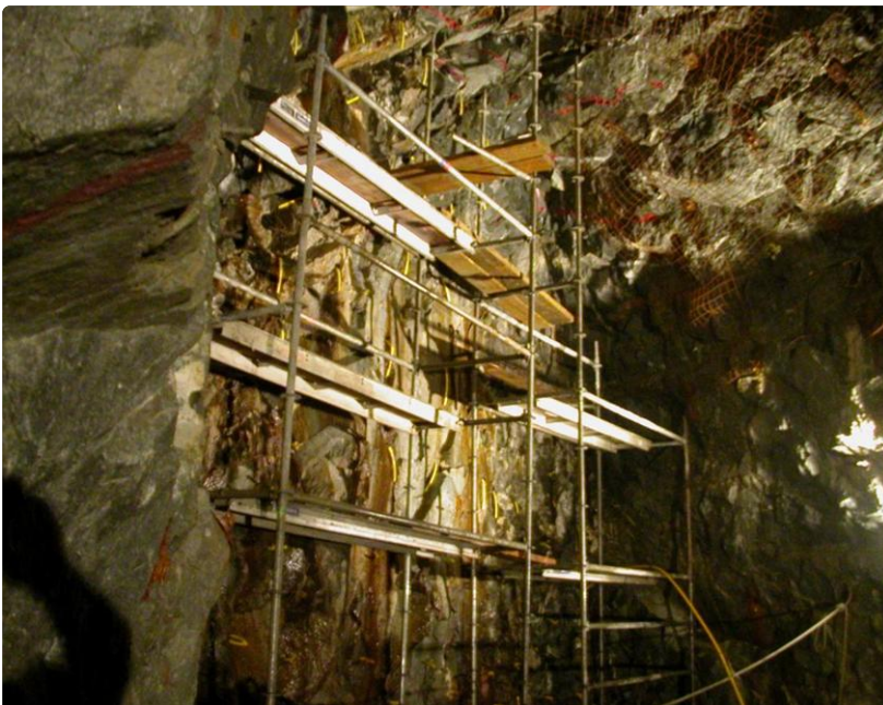
FIGURE 16 ÉCHAFFAUDAGE POUR LE CHARGEMENT
