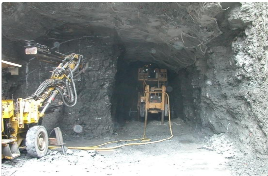
FIGURE 6 EXEMPLE DE SAUTAGE EN DEMI-VOLÉE (UTILISÉ PAR TALPA INC. AU METRO DE LAVAL)
