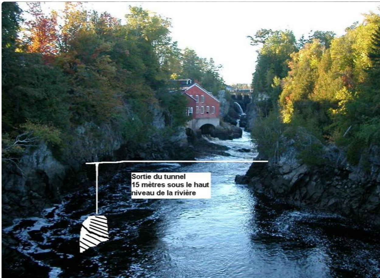
FIGURE 3 SORTIE DU TUNNEL SOUS L'EAU
