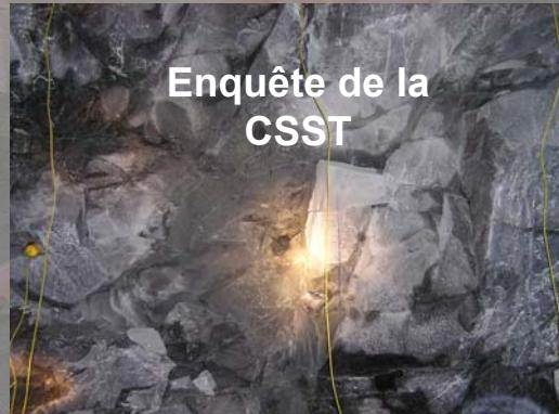
Détonation d'explosifs dans deux trous de mine dans un front de taille souterrain en chargement de la mine Lapa. (2008)
