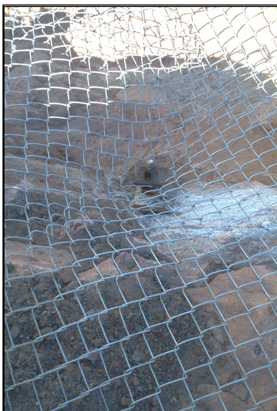
Photo 14: Vue rapprochée de l'épinglage du treillis métallique.
