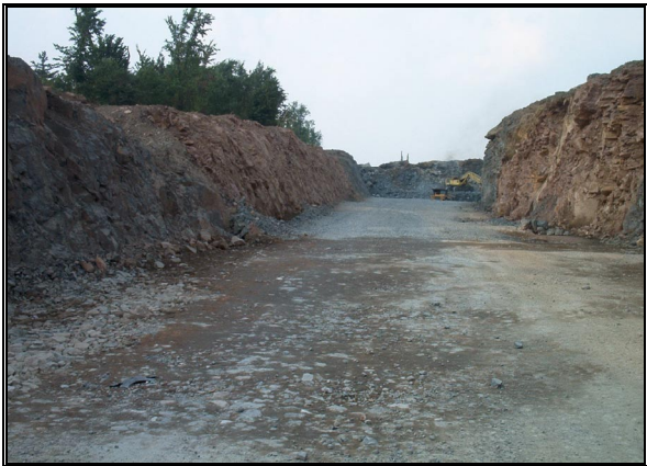
Photos 5 et 6: Suite aux étapes 1 et 2, excavation jusqu'à la ligne de centre de la chaussée.
