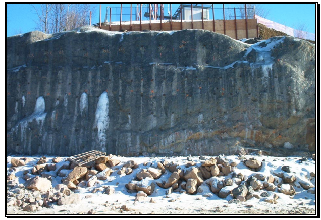
Photo 8: Paroi finale une fois l'excavation complétée.
