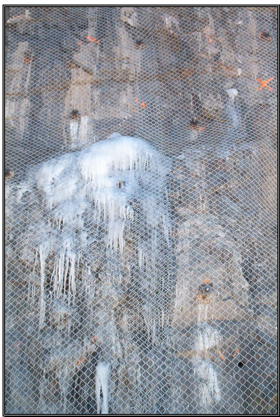
Photo 13: Ancrages, treillis métallique et barbacanes.
