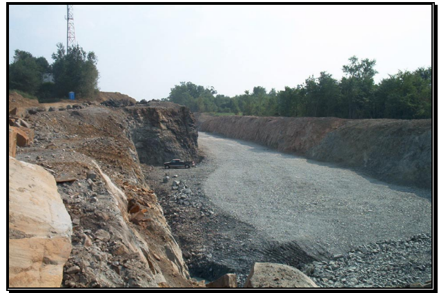
Photos 5 et 6: Suite aux étapes 1 et 2, excavation jusqu'à la ligne de centre de la chaussée.
