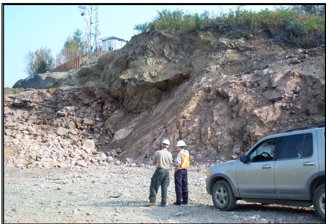
Photo 11: Plan à 46° de pendage avec instabilités.
