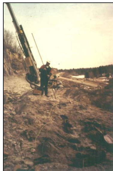
Photo 4: Le positionnement de la foreuse est une étape cruciale sur la qualité de l'orientation et l'inclinaison du trou de forage.
