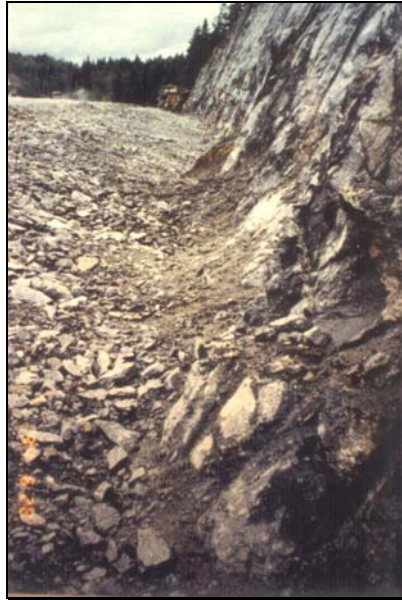
Photo 6: Déviation des trous de prédécoupage qui a pour conséquence de réduire la section du fossé.
