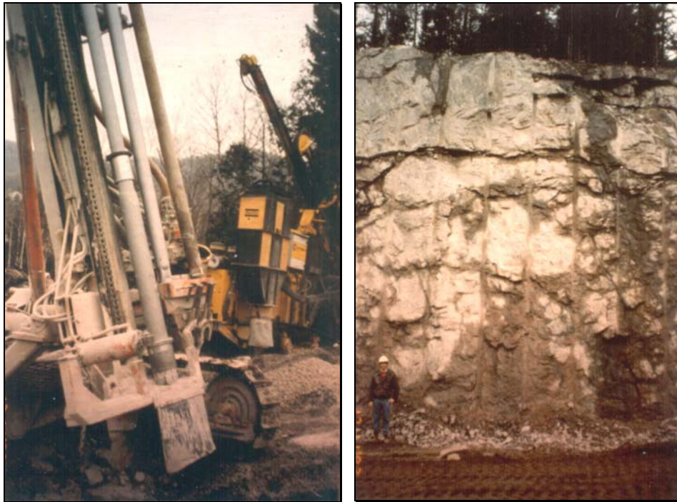
Photos 8 et 9: Foreuse à marteau fond de trou avec un espacement de 1200 mm.
