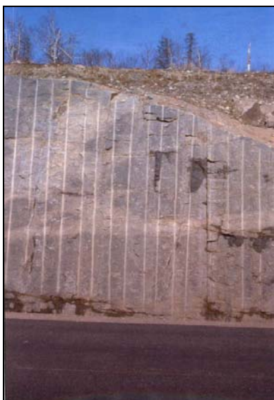
Photo 3: Un espacement régulier est un pré-requis à la réussite du prédécoupage.
