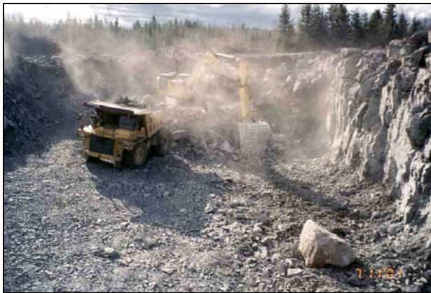
Photo 13: Excavation du front d'abattage.
