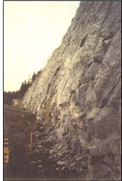
Photo 7: Reprise à la base de la paroi pour corriger la situation montrée à la photo 6.
