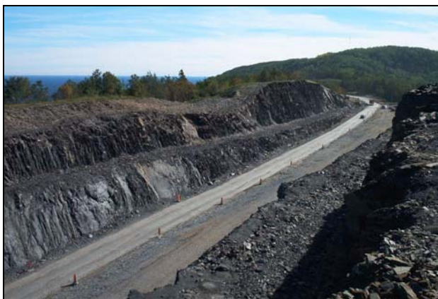
Photo 10: Les paliers sont conçus de façon à être horizontaux dans le sens longitudinal et avec une légère pente vers le massif dans le sens transversal.
