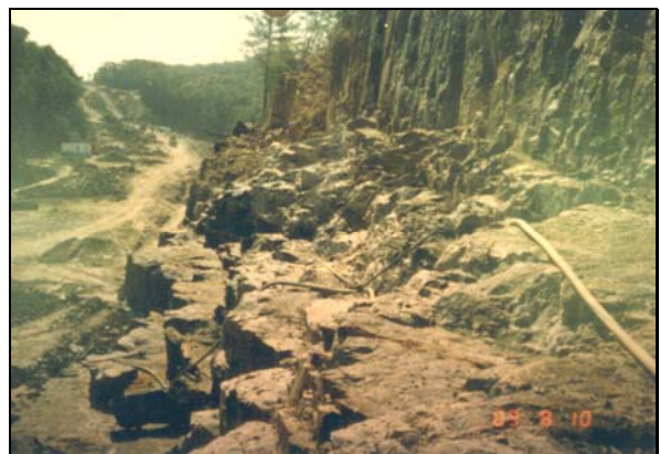
Photo 11: Palier avec pente vers la route dû à un mauvais contrôle de la profondeur des forages.
